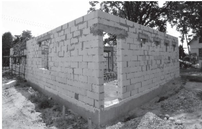
Trwają prace budowlane przy świetlicy wiejskiej we Wróblowicach.
